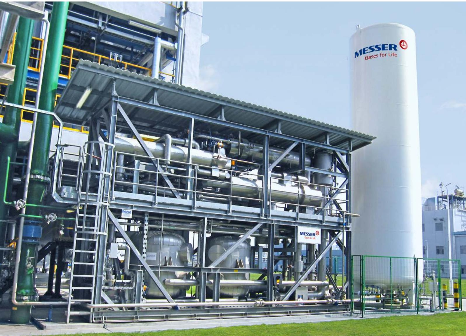
Rückgewinnungsanlage für Methylchlorid
