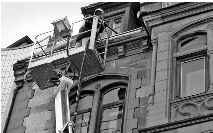
Die Reinigung mit Trockeneis schont Fassade und Umwelt.
