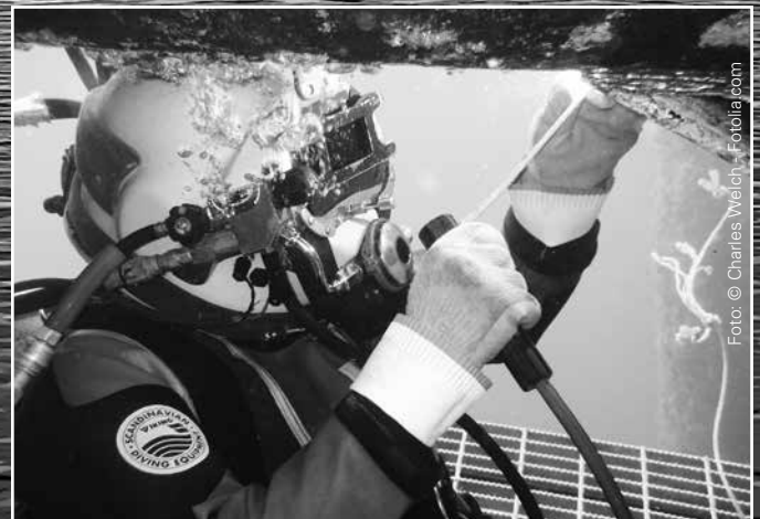
Schweißarbeiten sind nicht nur bei Neubauten notwendig, sondern auch bei Reparaturen an bestehenden Anlagen.
