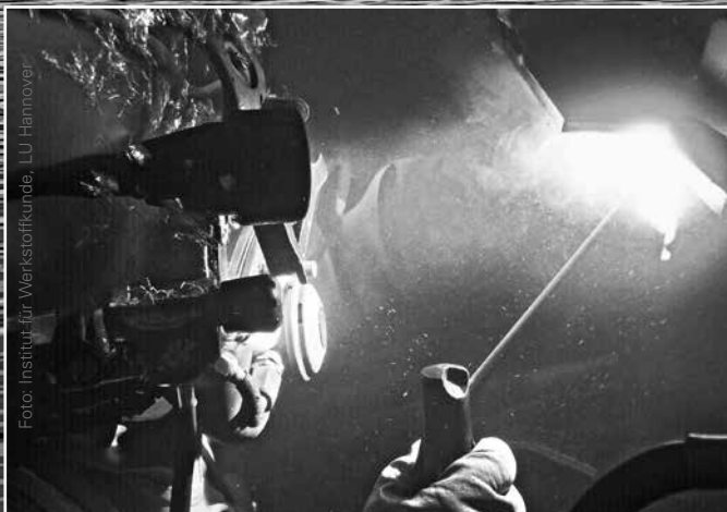
Bisher ist das Schweißen der unterseeischen Stahlkonstruktionen nur mit dem Lichtbogenhandverfahren möglich.
